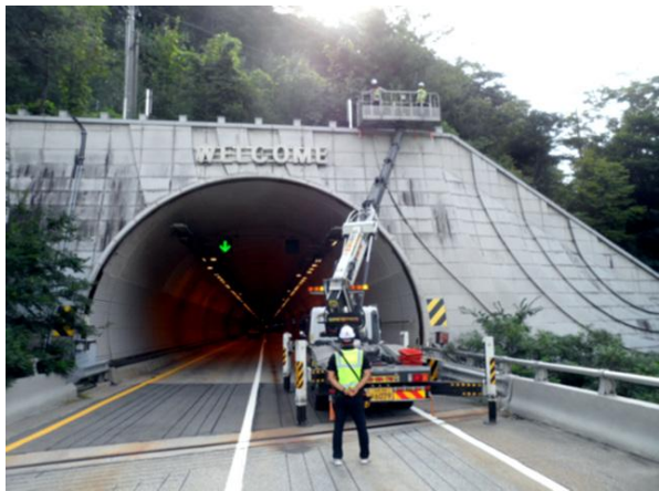
고소점검차를 이용한 근접조사
